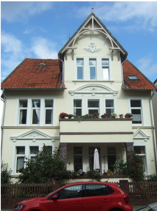
Das erhalten gebliebene Haus Humboldtstraße 14 bewohnte Fahrenholz im Erdgeschoss von 1914 bis 1927. (Foto: Häger)
